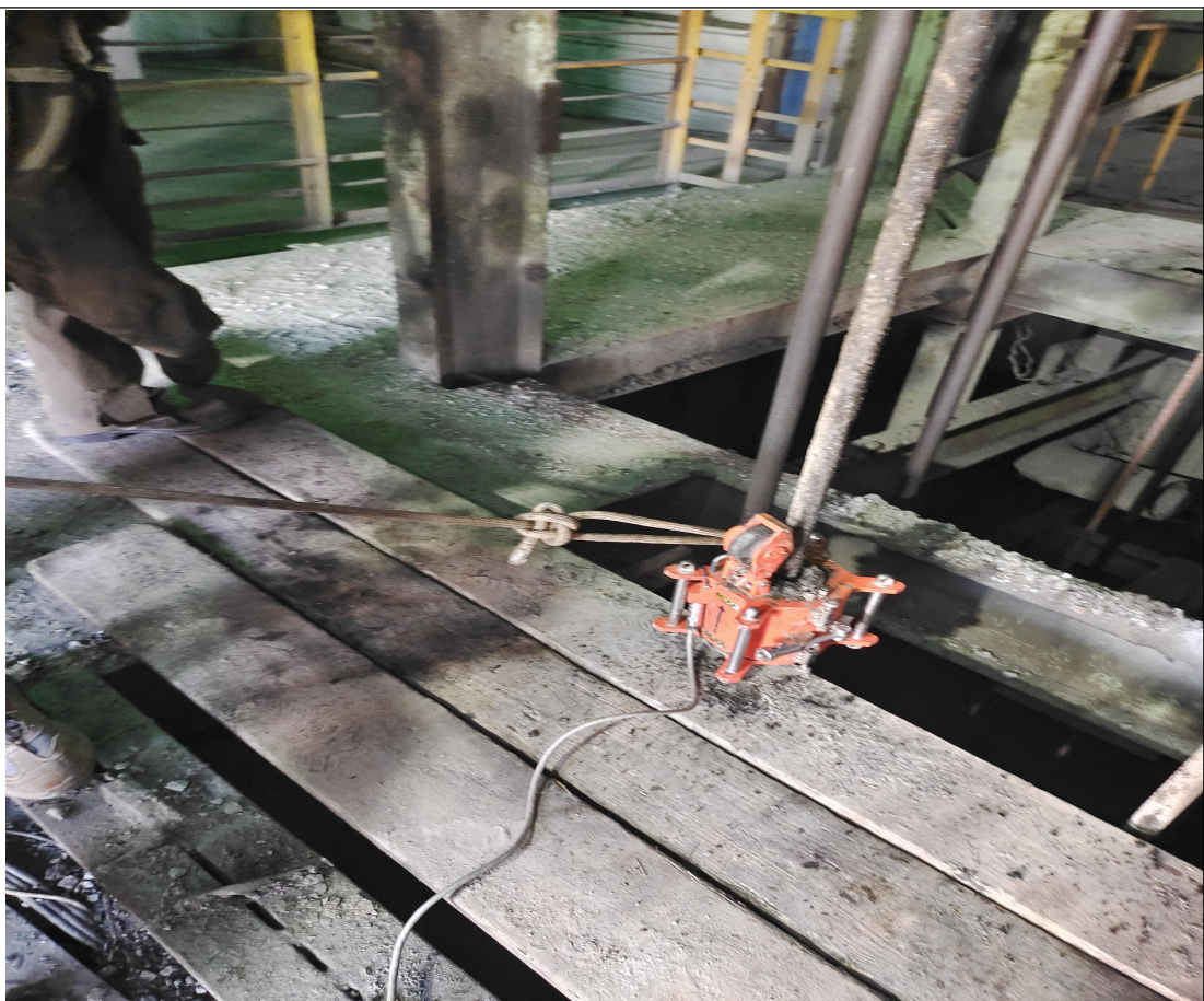
现场检测照片
