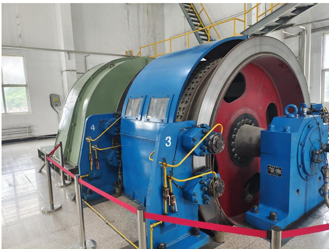
现场检测照片
