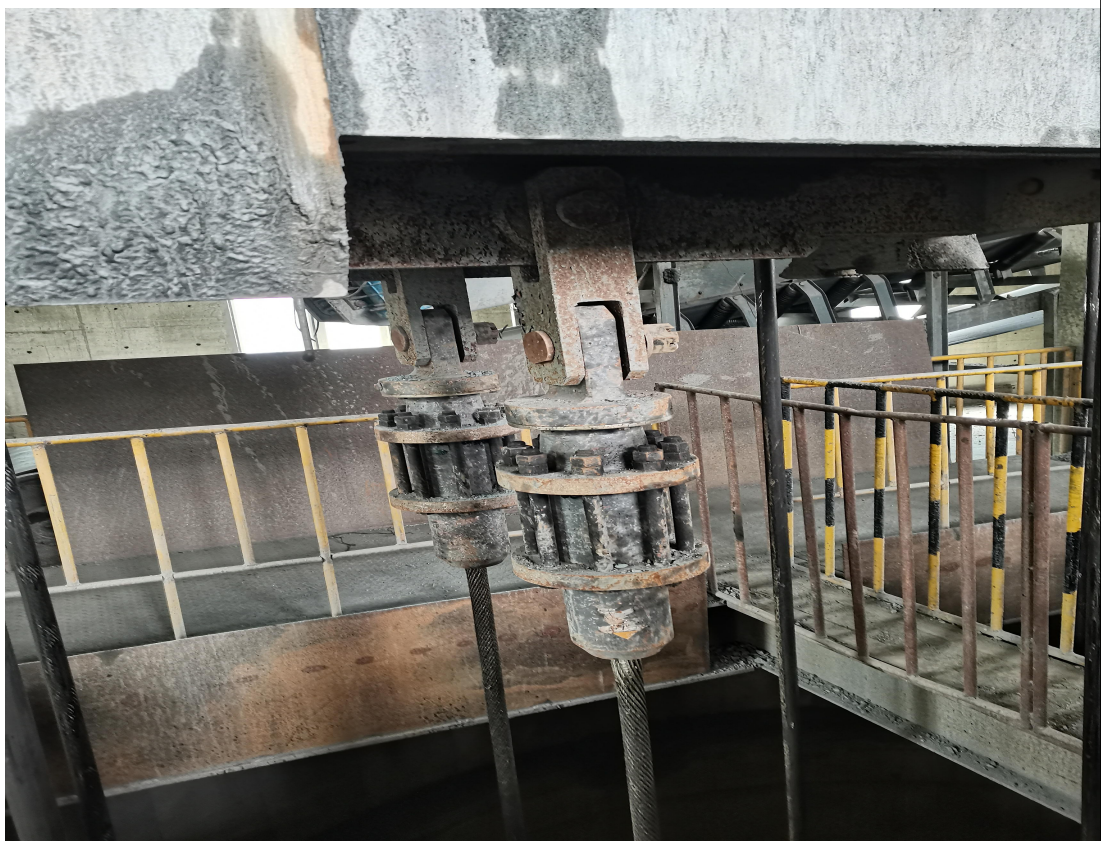
现场检测照片
