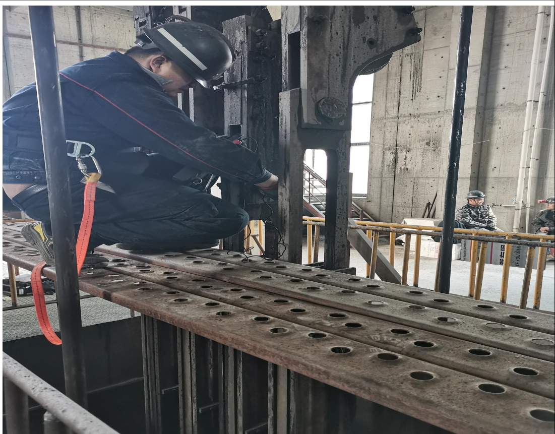
现场检测照片
