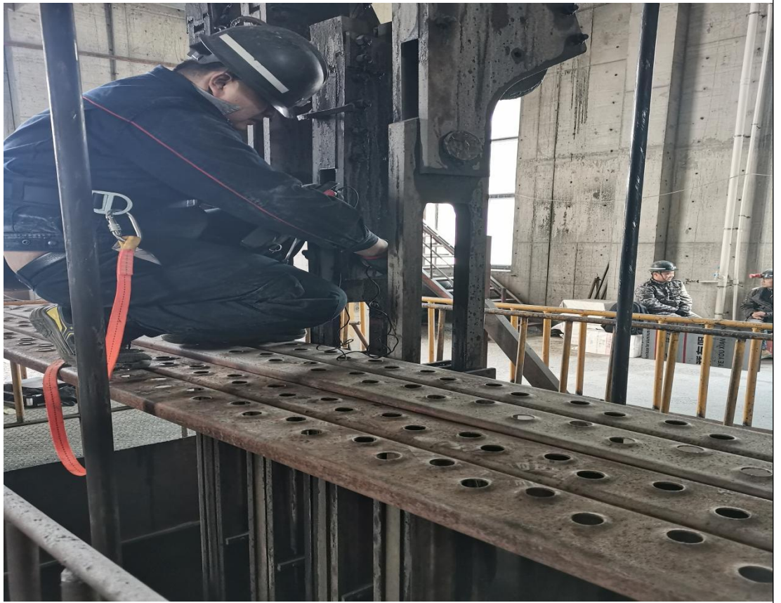
现场检测照片
