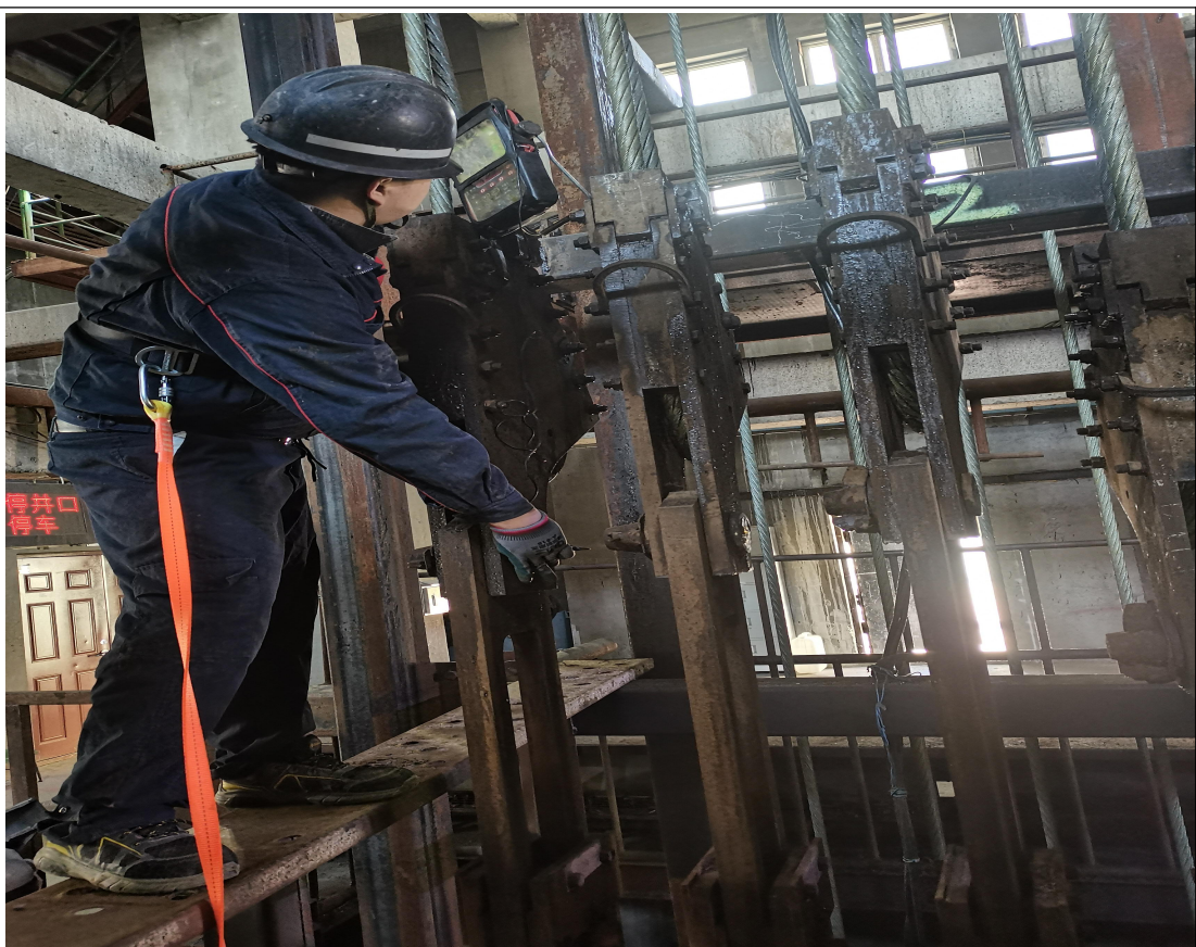
现场检测照片
