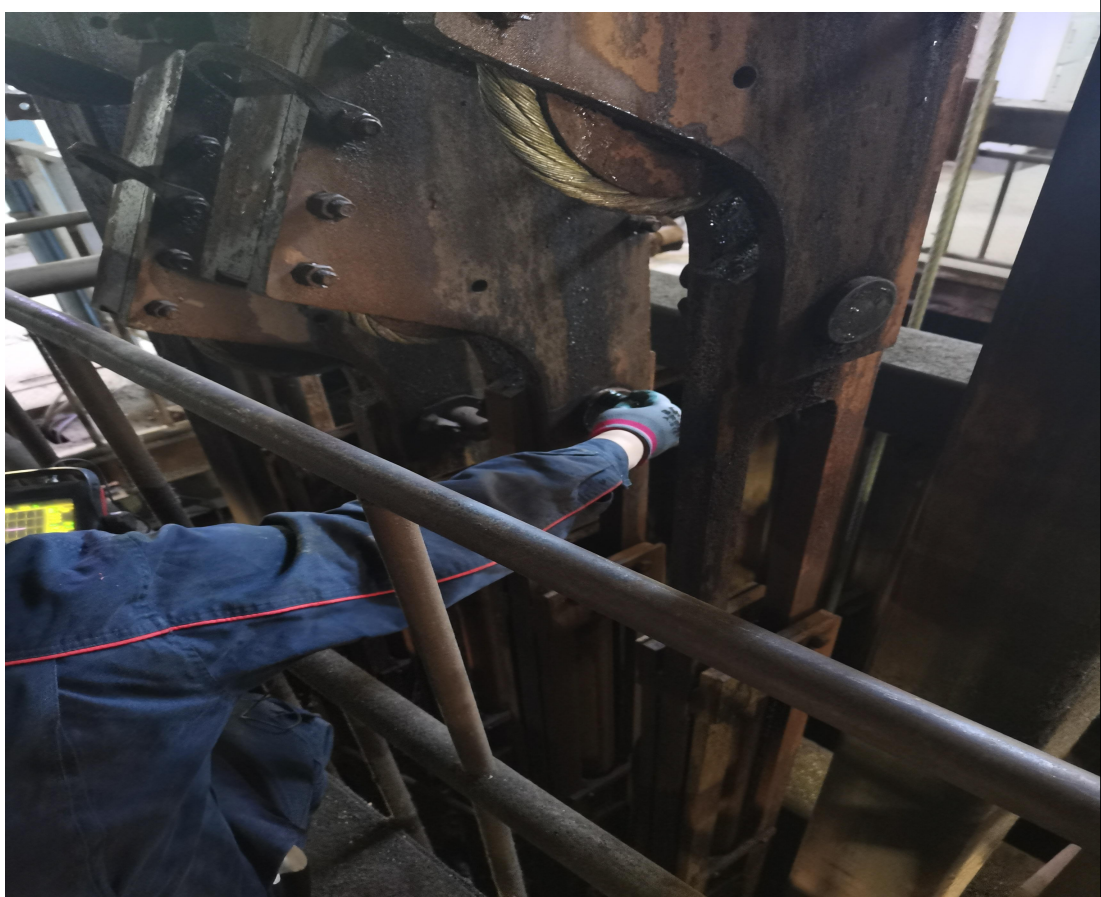
现场检测照片
