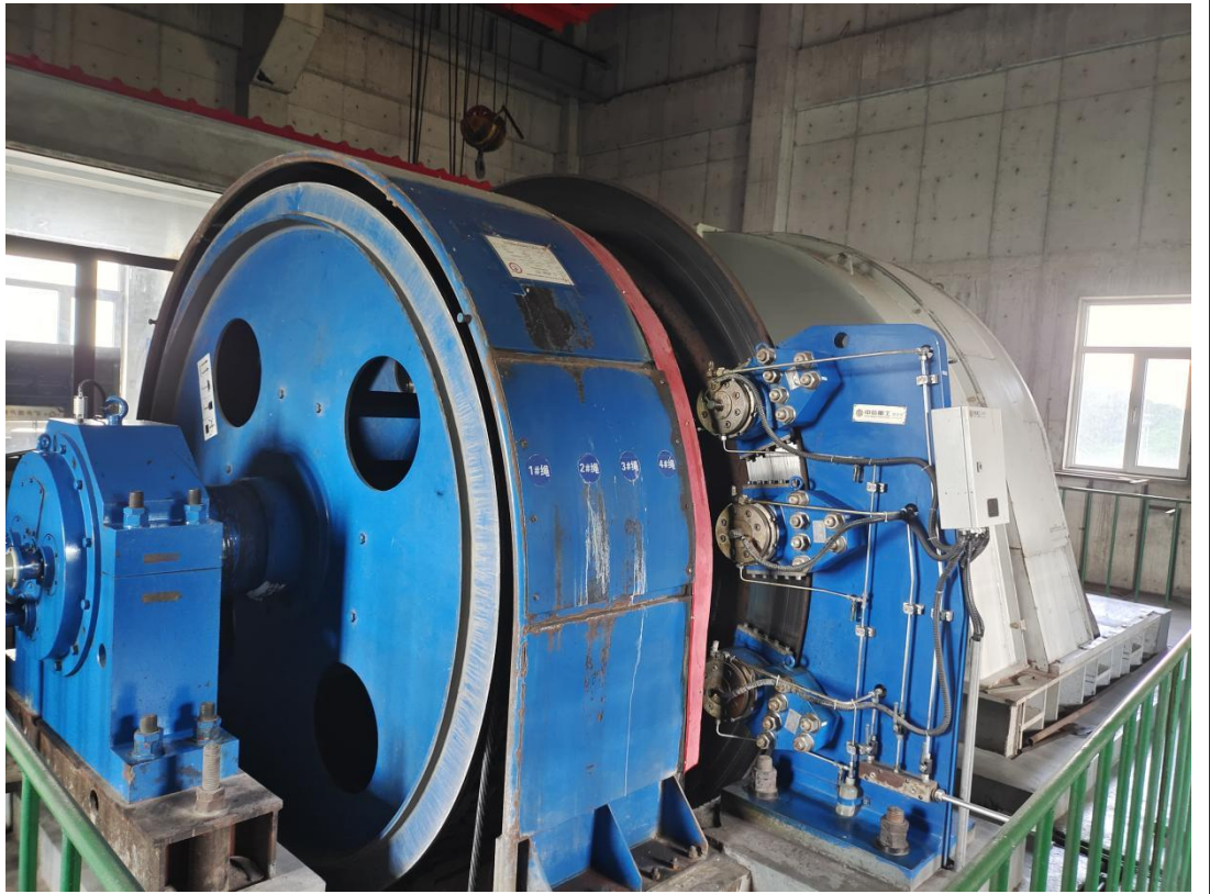
现场检测照片
