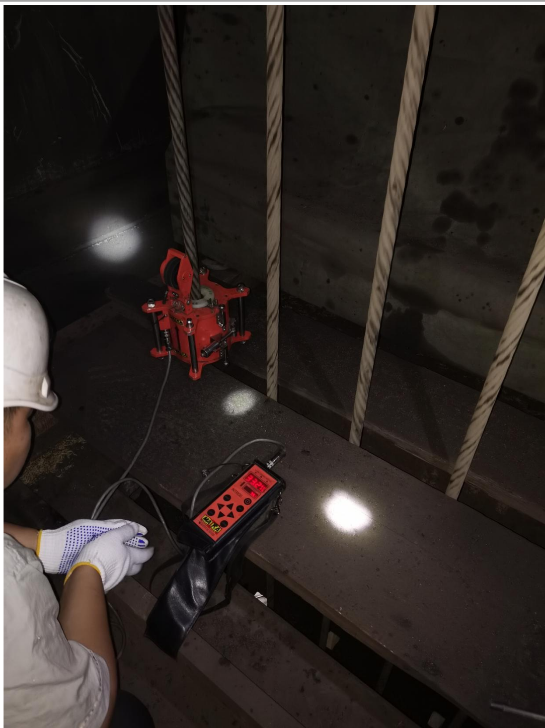
现场检测照片
