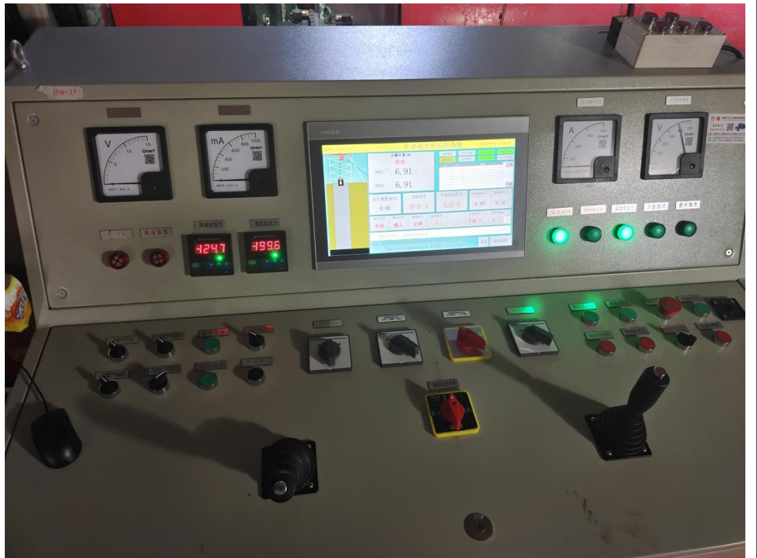
现场检测照片
