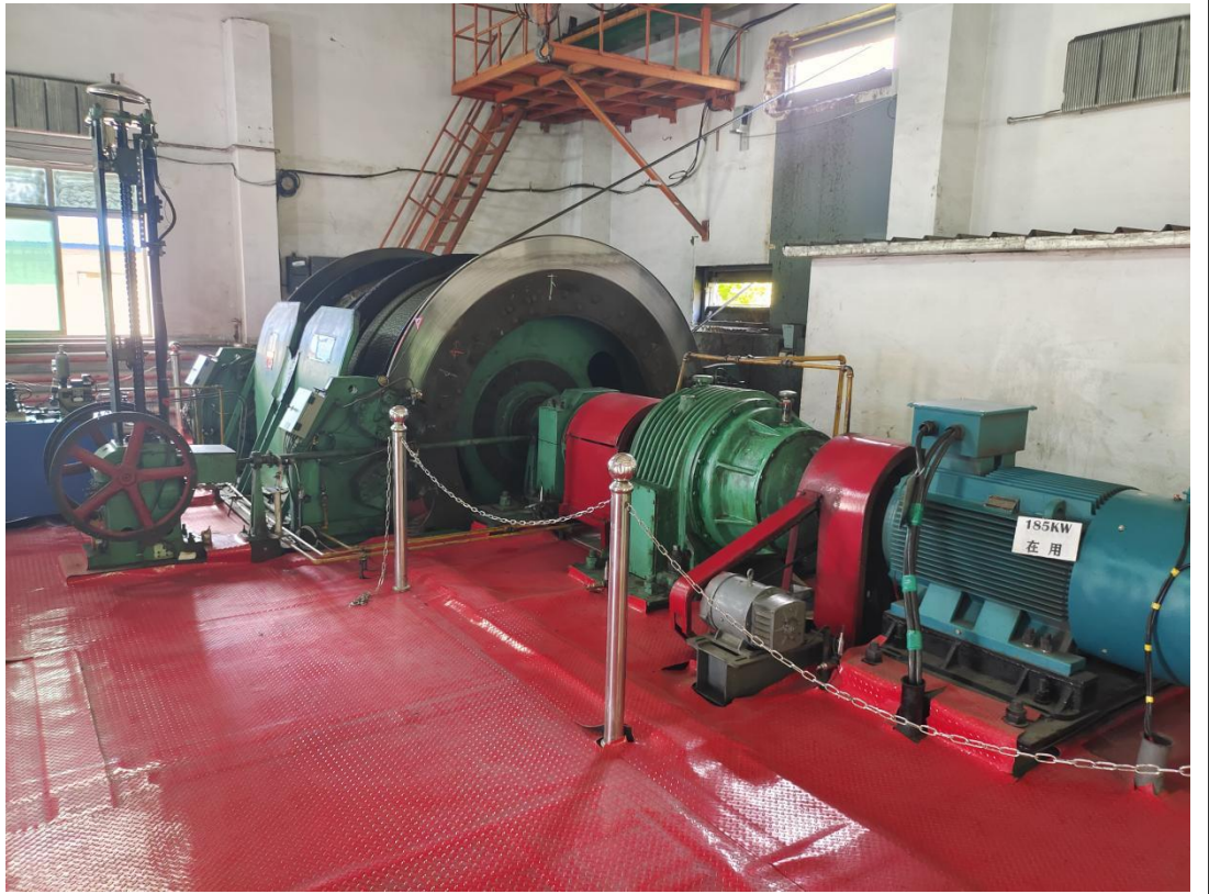
现场检测照片
