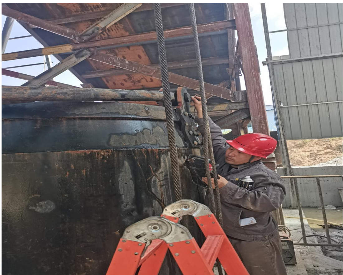
现场检测照片
