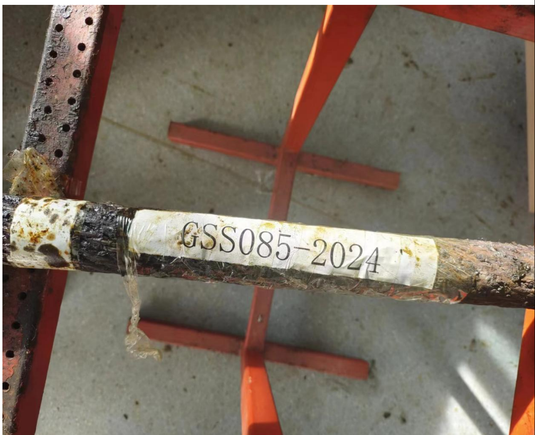
现场检测照片
