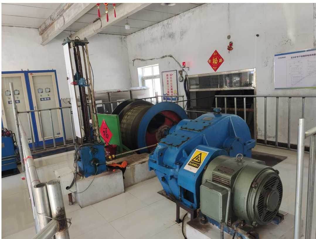
现场检测照片
