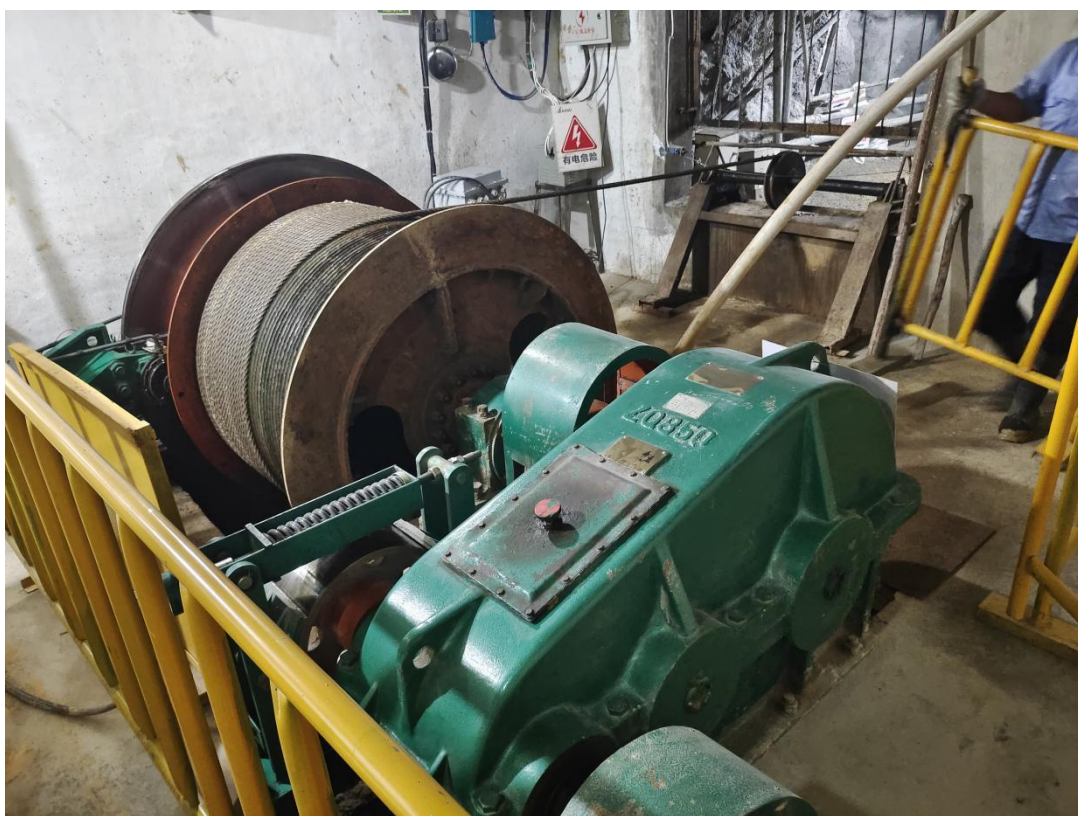
现场检测照片
