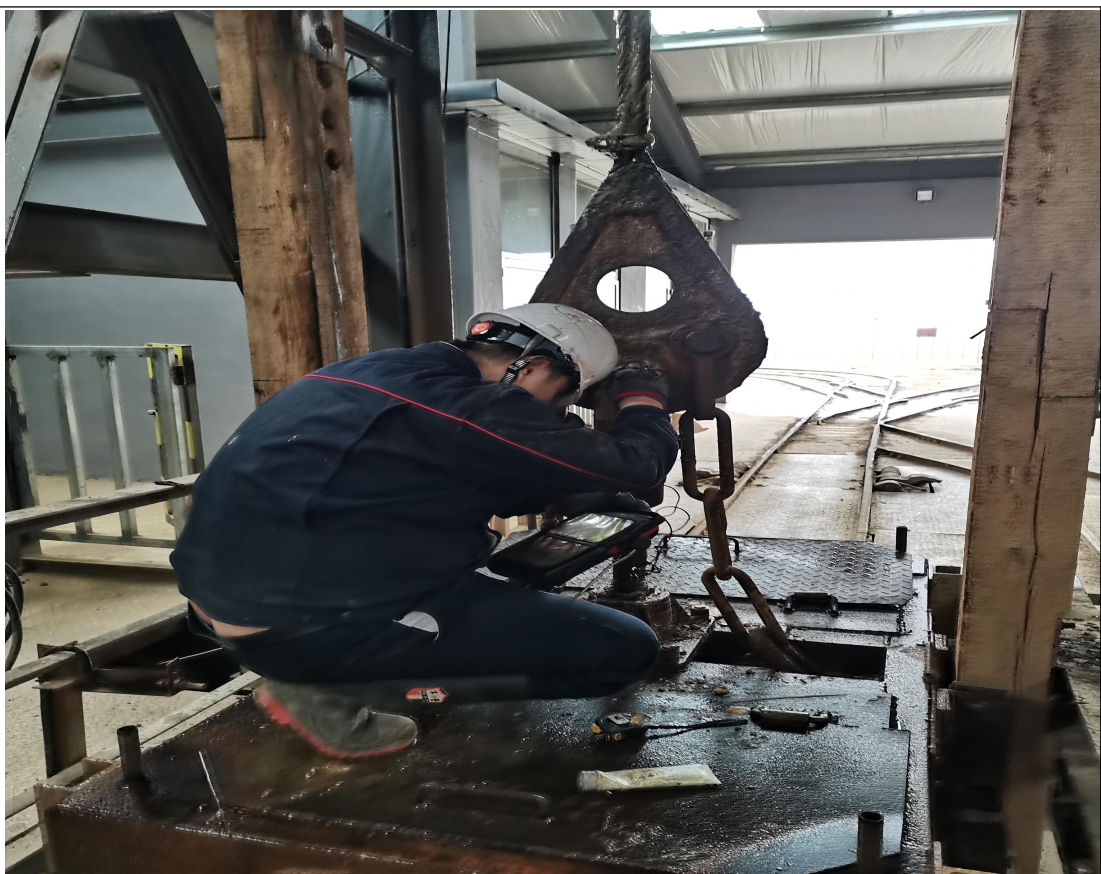
现场检测照片
