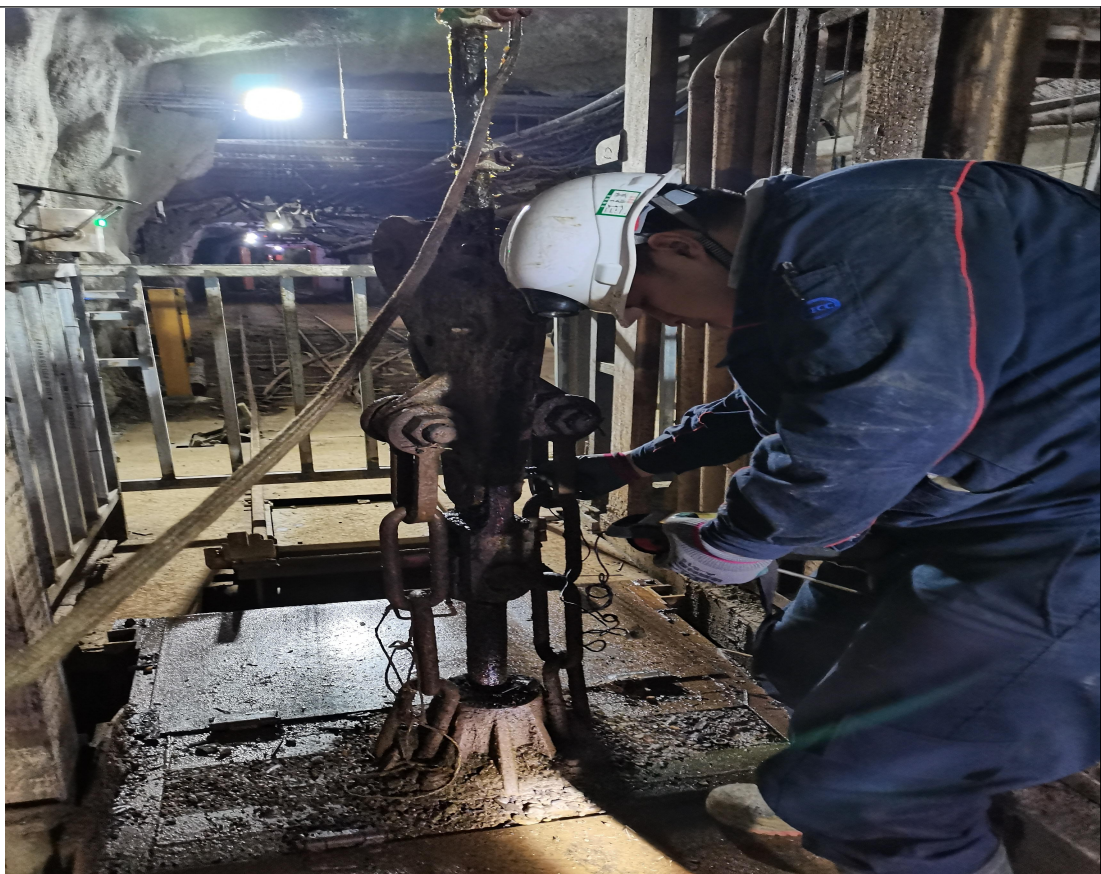
现场检测照片
