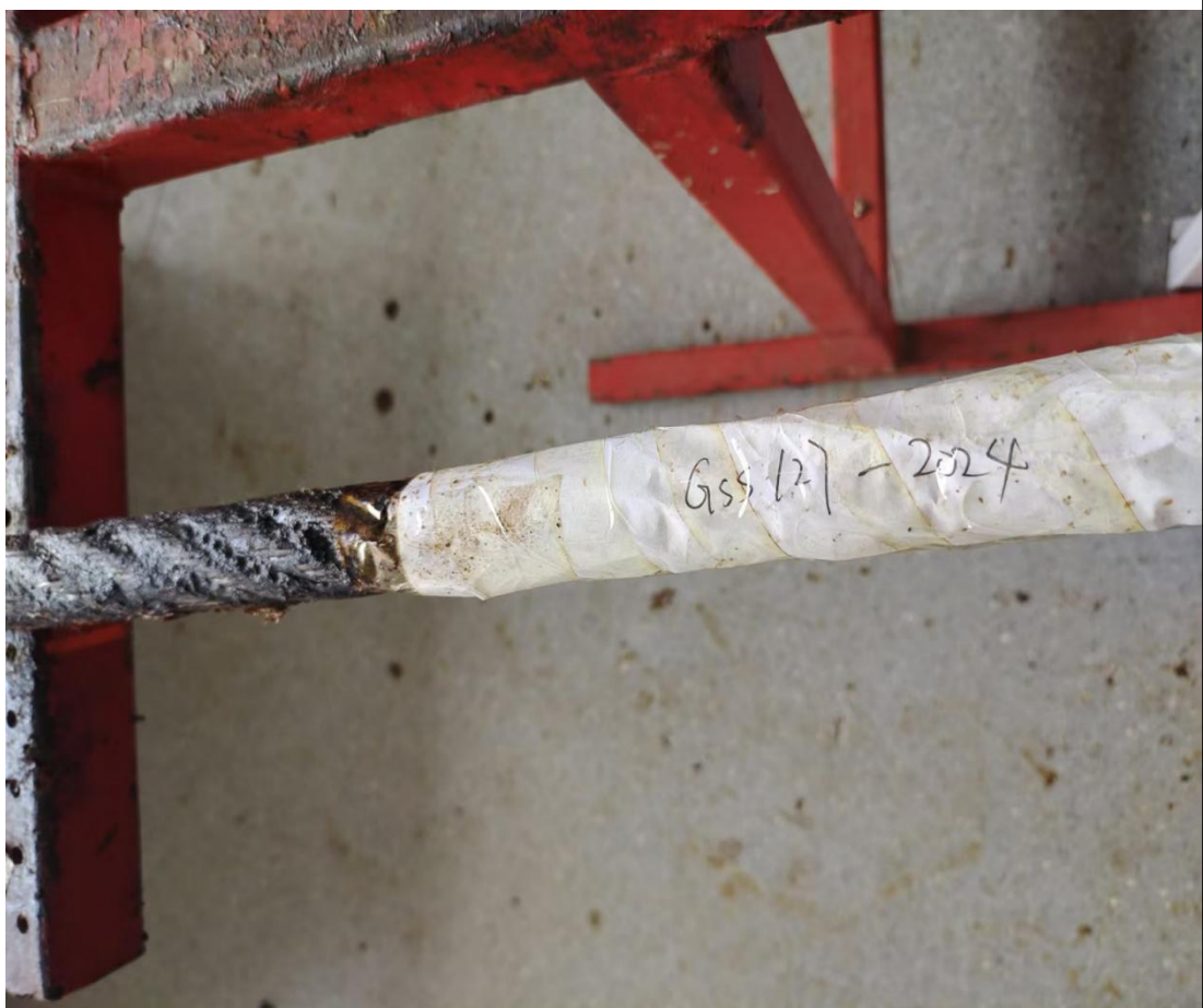
现场检测照片
